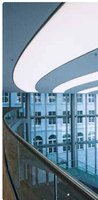
Heiz-/Kühldecke in Kombination mit einer separat gekühlten Lichtdecke
