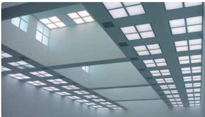
VARICOOL Uni Heiz-/Kühldeckensystem in einem Museumsgebäude
