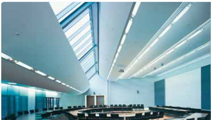
Fertiggestellte Heiz-/Kühldecke in leicht gebogener Ausführung (Sonderkonstruktion)
