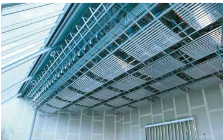
Heiz-/Kühldecke vor der Beplankung mit Thermoplaten
